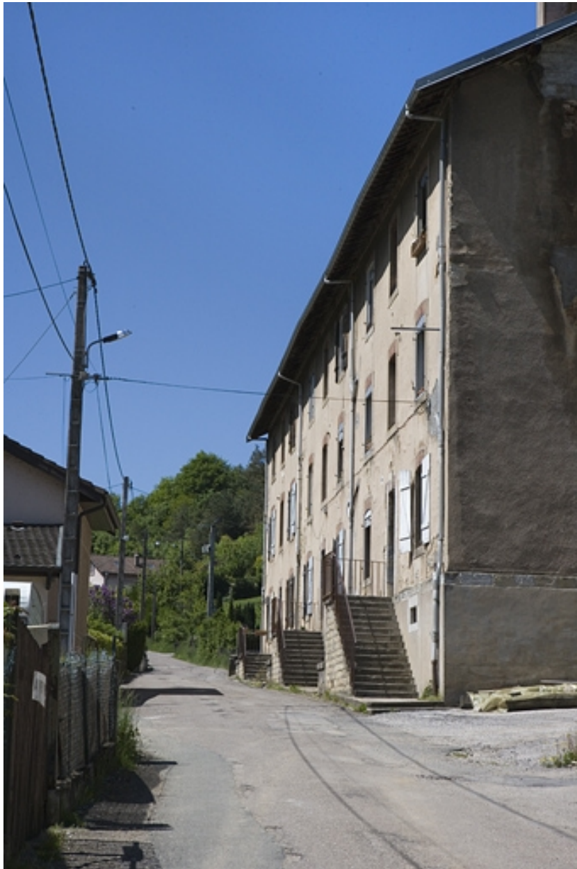
Logement d'ouvriers (rue du Tâtre). Façade antérieure.
