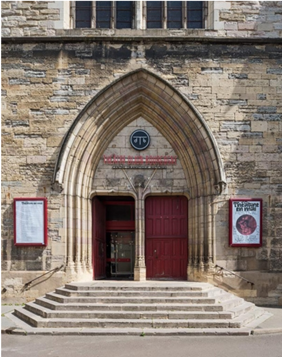
Façade occidentale : entrée.
