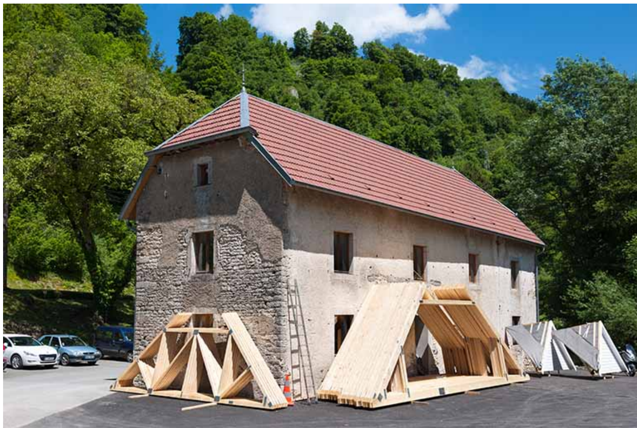
Bâtiment agricole depuis le sud-ouest.
