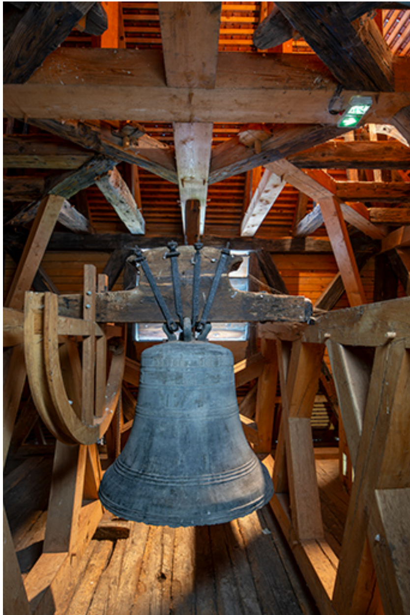
Charpente du beffroi : la cloche et son joug.
