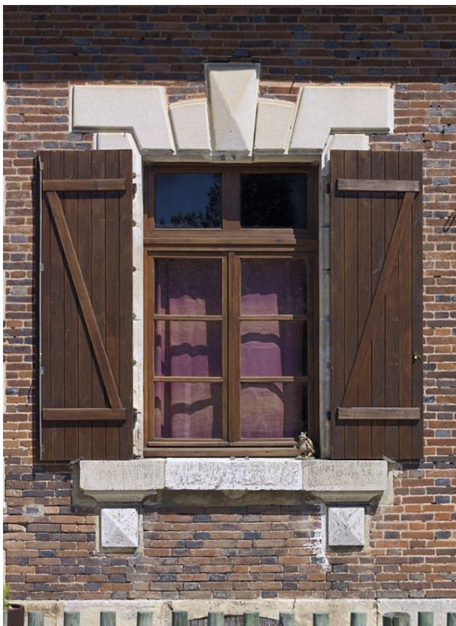
Maison éclusière : détail de la fenêtre.
