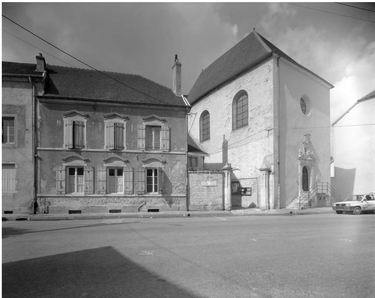
Vue d'ensemble depuis la rue.
