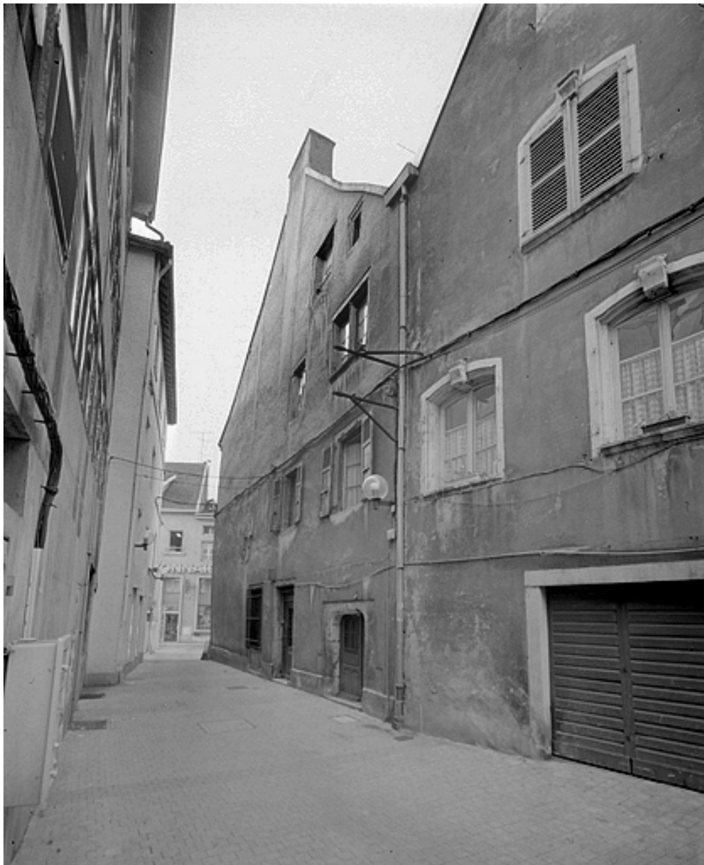
Façade sur la rue Saint-Martin.
