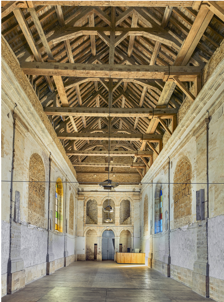
La nef, la charpente et la tribune.
