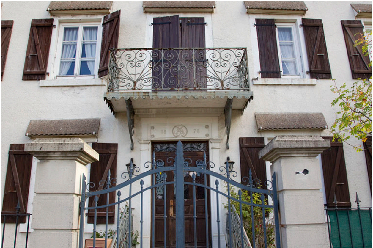
Logement patronal : porte d'entrée et balcon.
