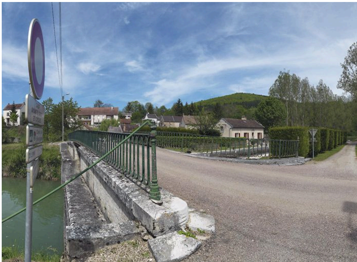
Pont vu d'aval.
