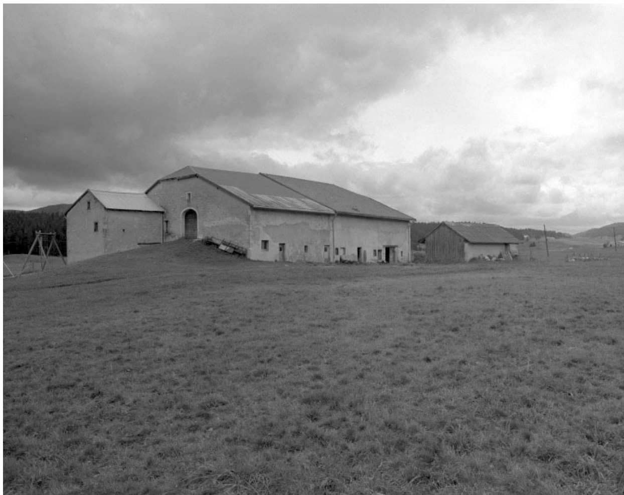
Façade postérieure des deux fermes mitoyennes.
