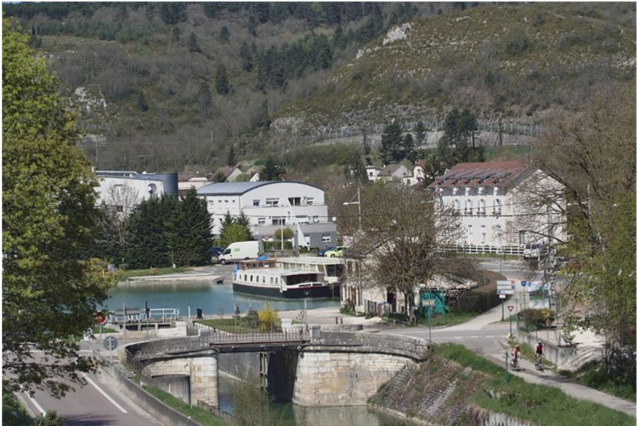
Vue d'ensemble du pont, vu de dessus.
