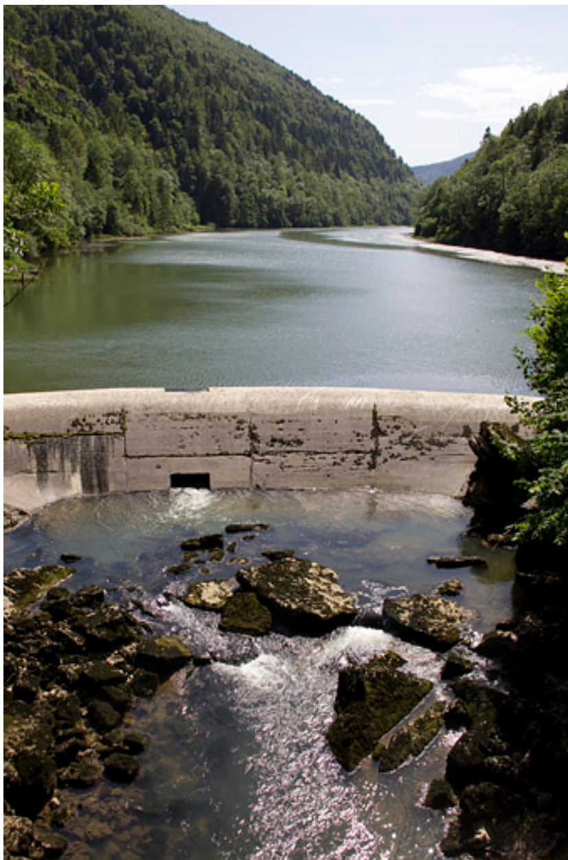
Barrage de la Goule : la retenue et le barrage, vus de l'aval.
