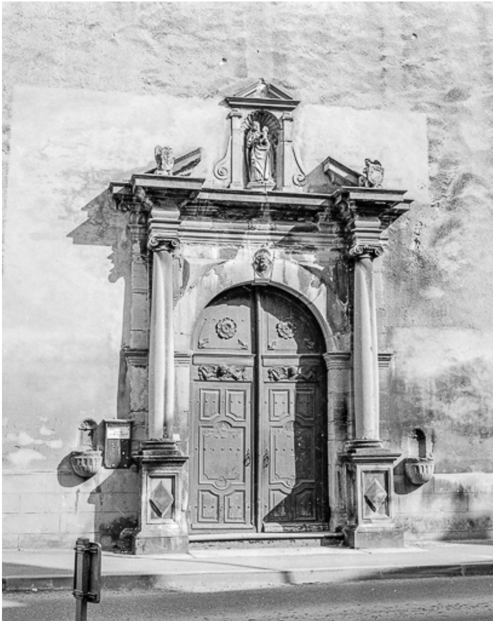
Portail de la façade antérieure : vue générale.
