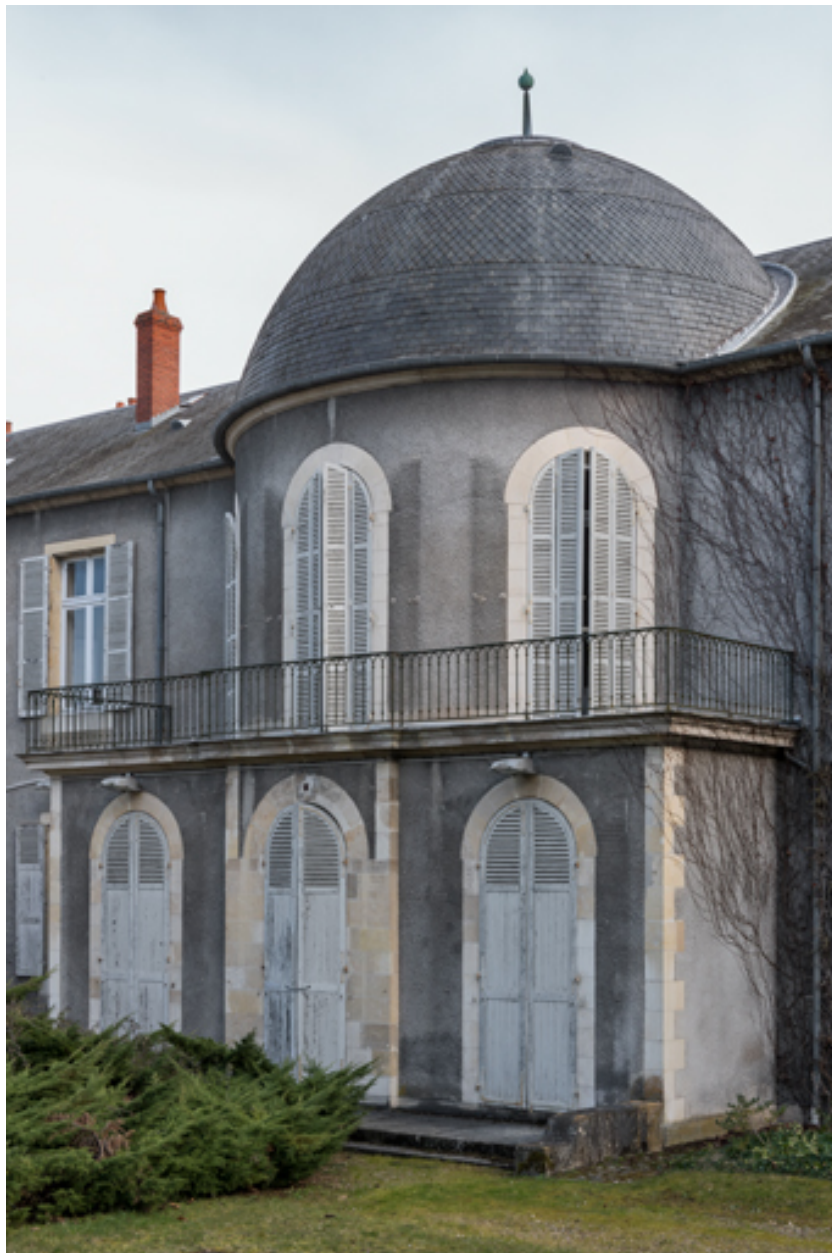
Façade sur le jardin, avant-corps.
