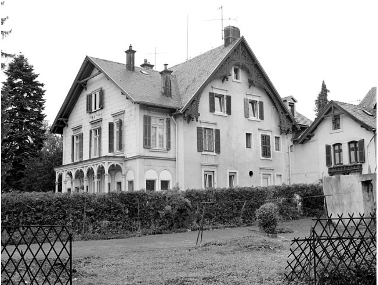
Façade orientale du logement principal.
