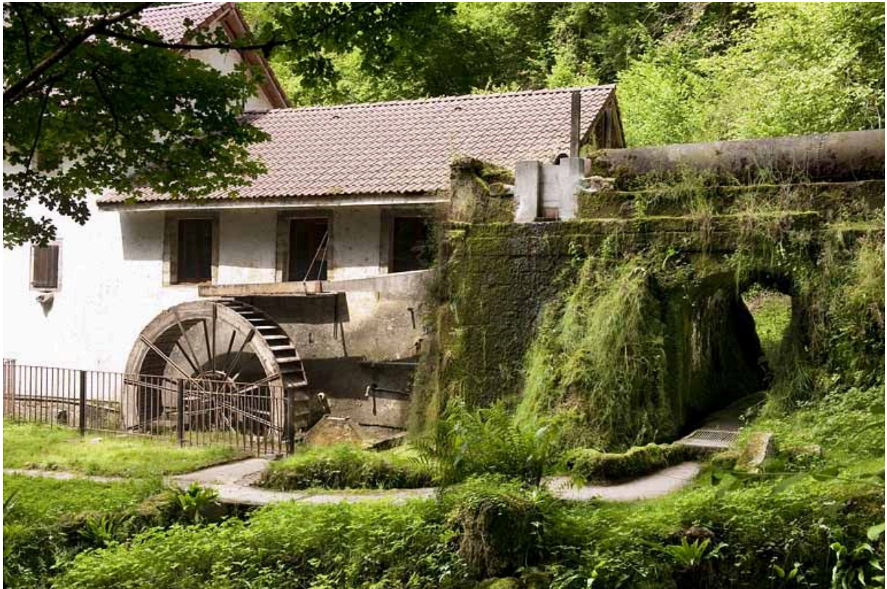
La conduite d'amenée et la roue hydraulique.
