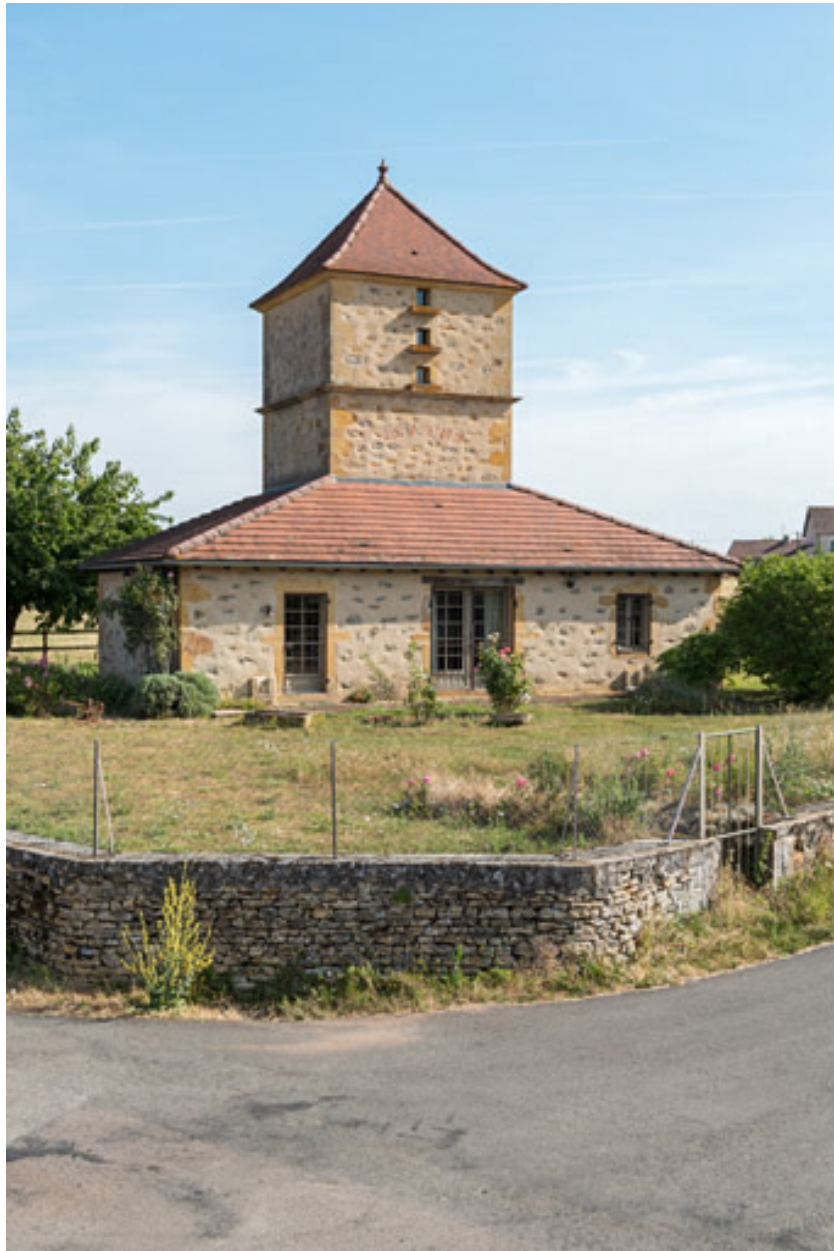
Habitation, surmontée d'un pigeonnier et érigée à la fin du XIXe siècle
