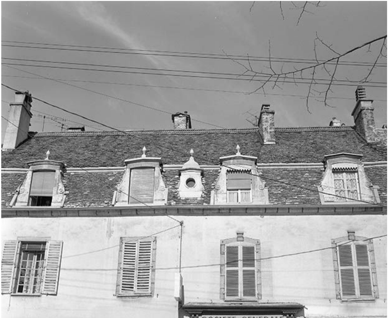
Maison (AE 48) 61 à 63 rue Pierre-Vernier : détail des baies de l'étage de comble.
