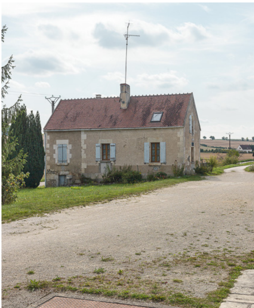
Vue de la maison éclusière.
