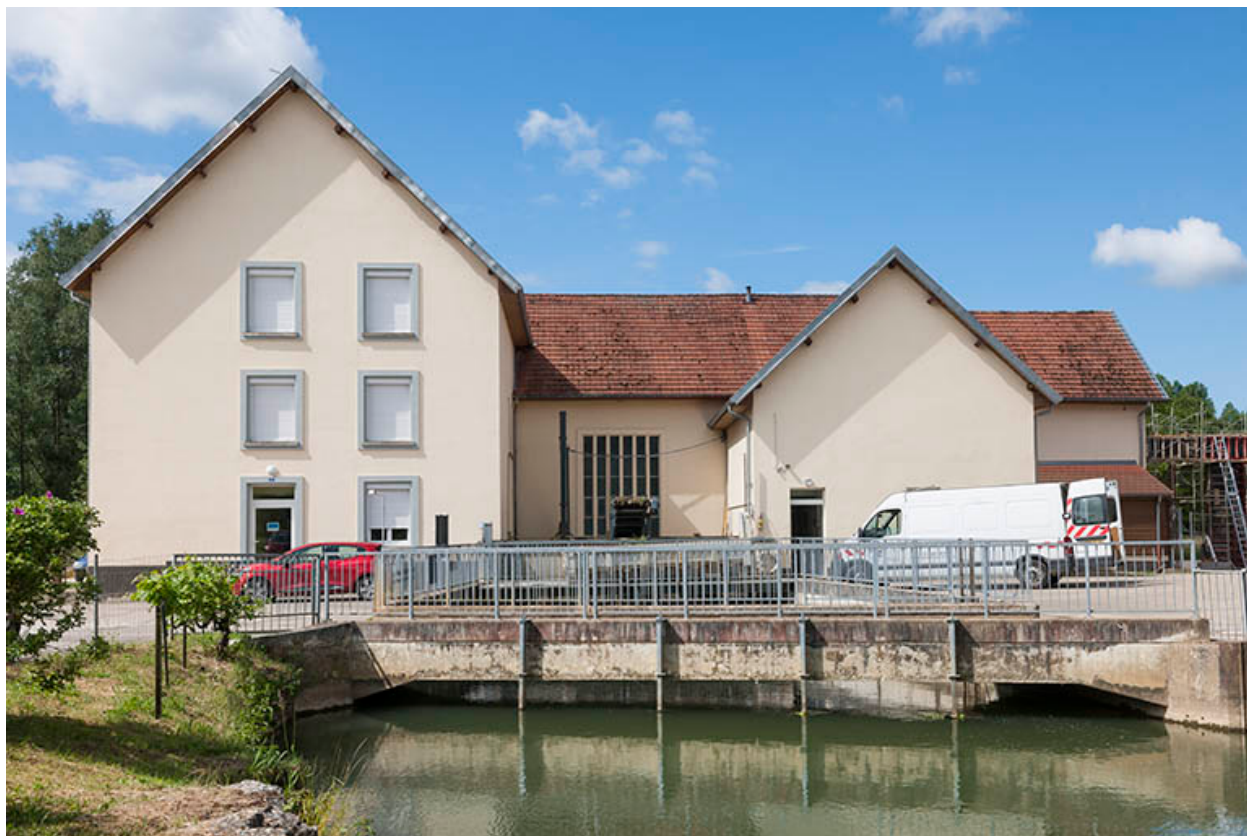
La centrale hydroélectrique depuis le canal d'amenée.
