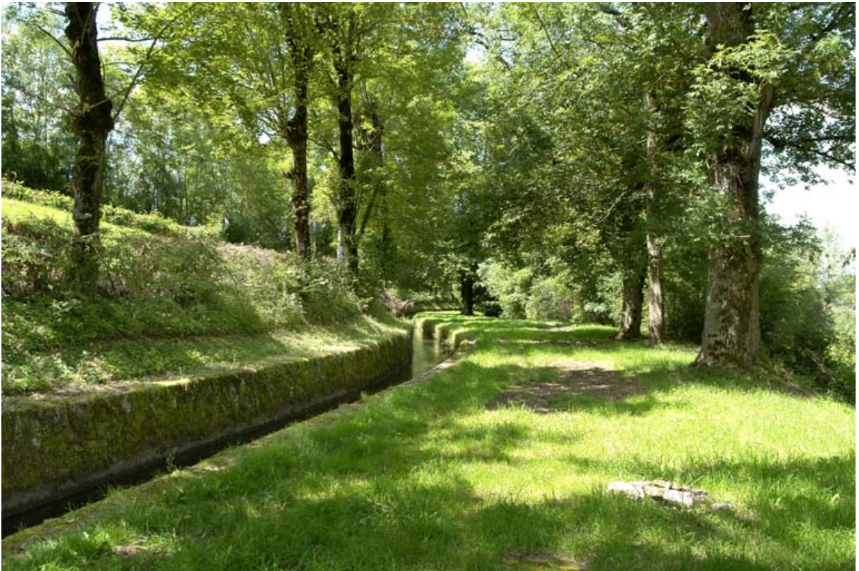
Rigole d'alimentation du canal en sortie du contre-réservoir.
