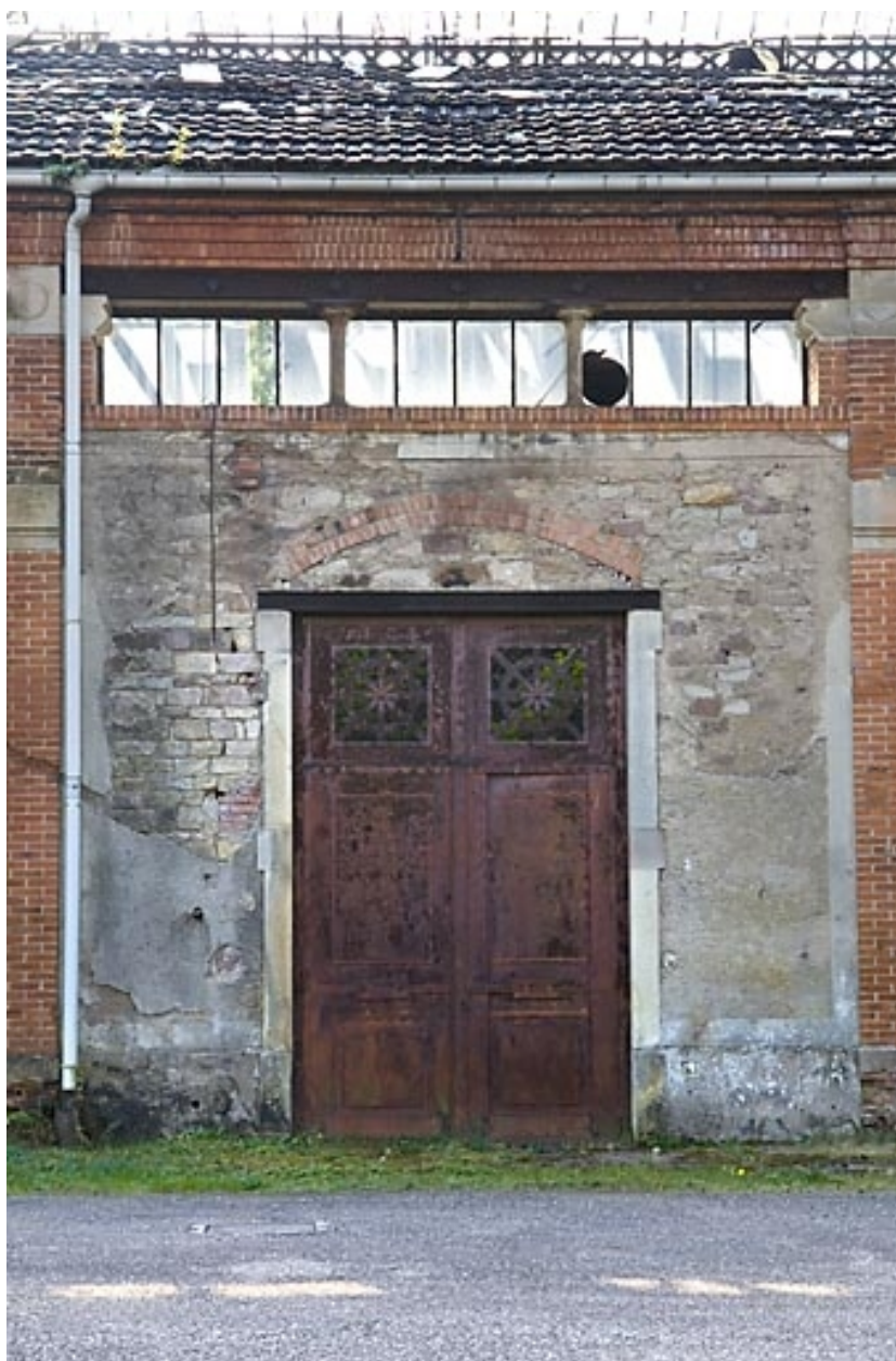
Façade antérieure. Détail d'une travée.
