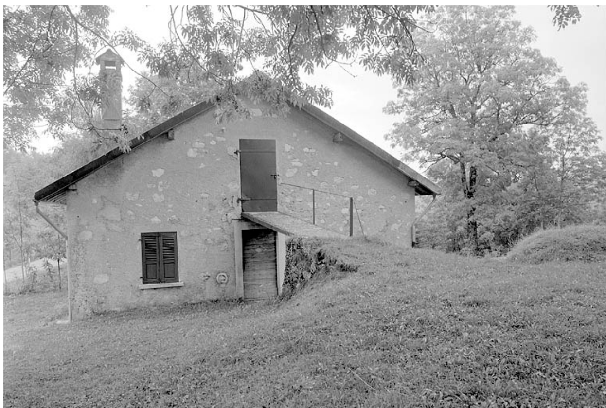
Face sud-ouest de la porcherie.
