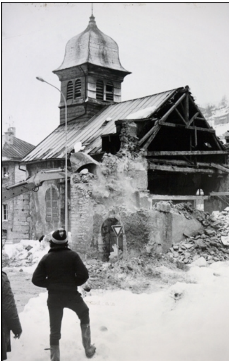
[Démolition du chœur de l'église], 1981
