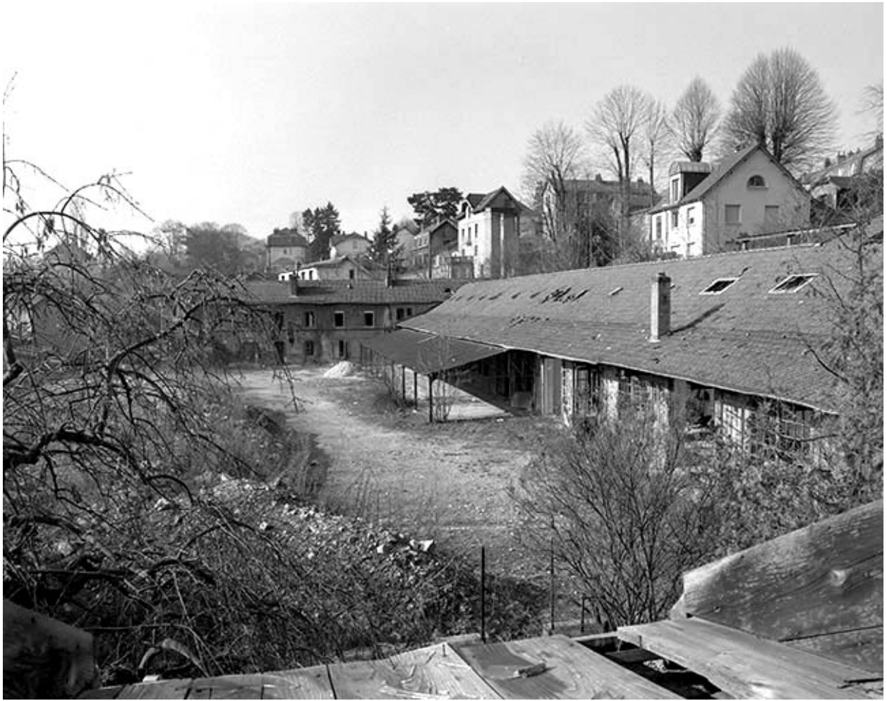
Logement d'ouvriers (21) et menuiserie.
