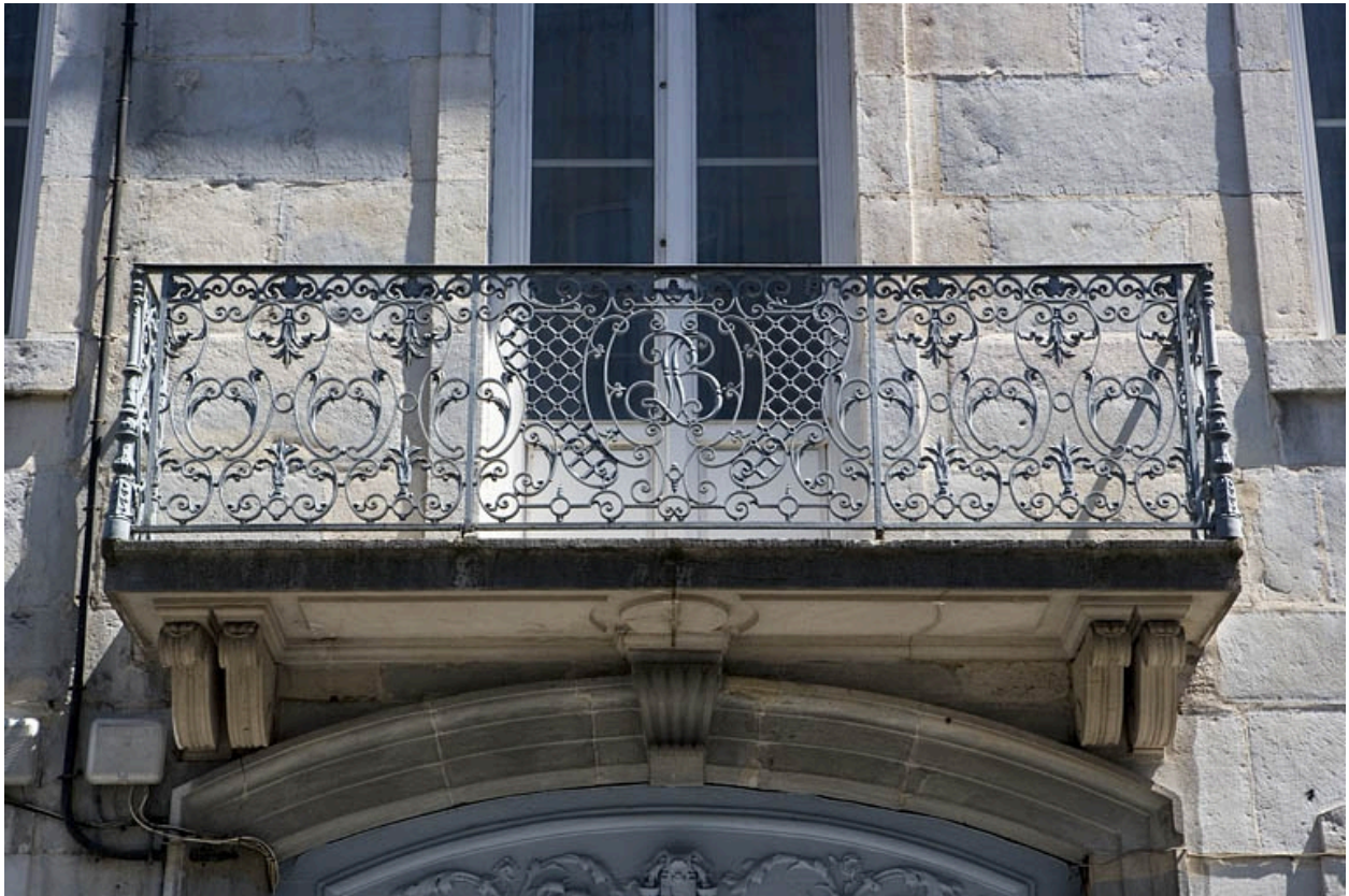
Logis principal : détail du balcon situé au-dessus du portail d'entrée.
