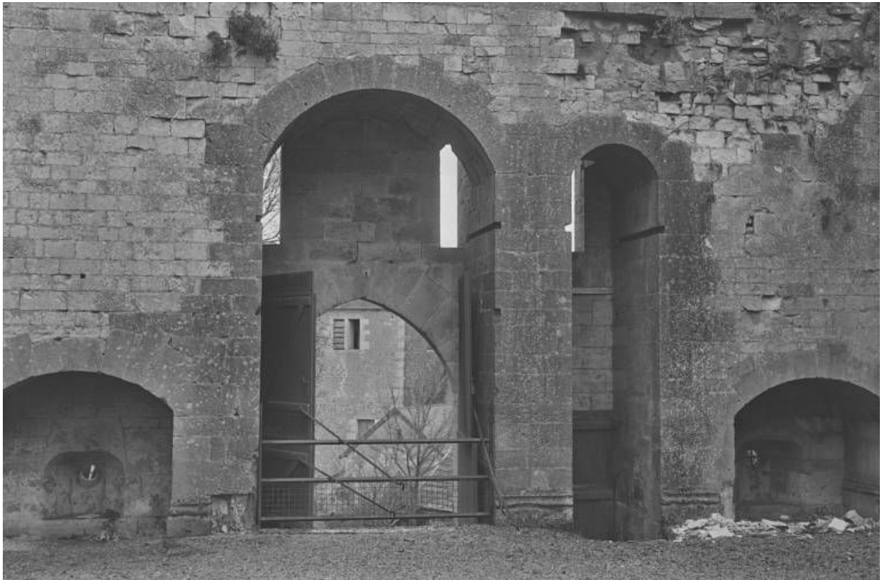
Ancien dispositif d'entrée. Détail : la porte et la poterne (photo prise en 1969).
