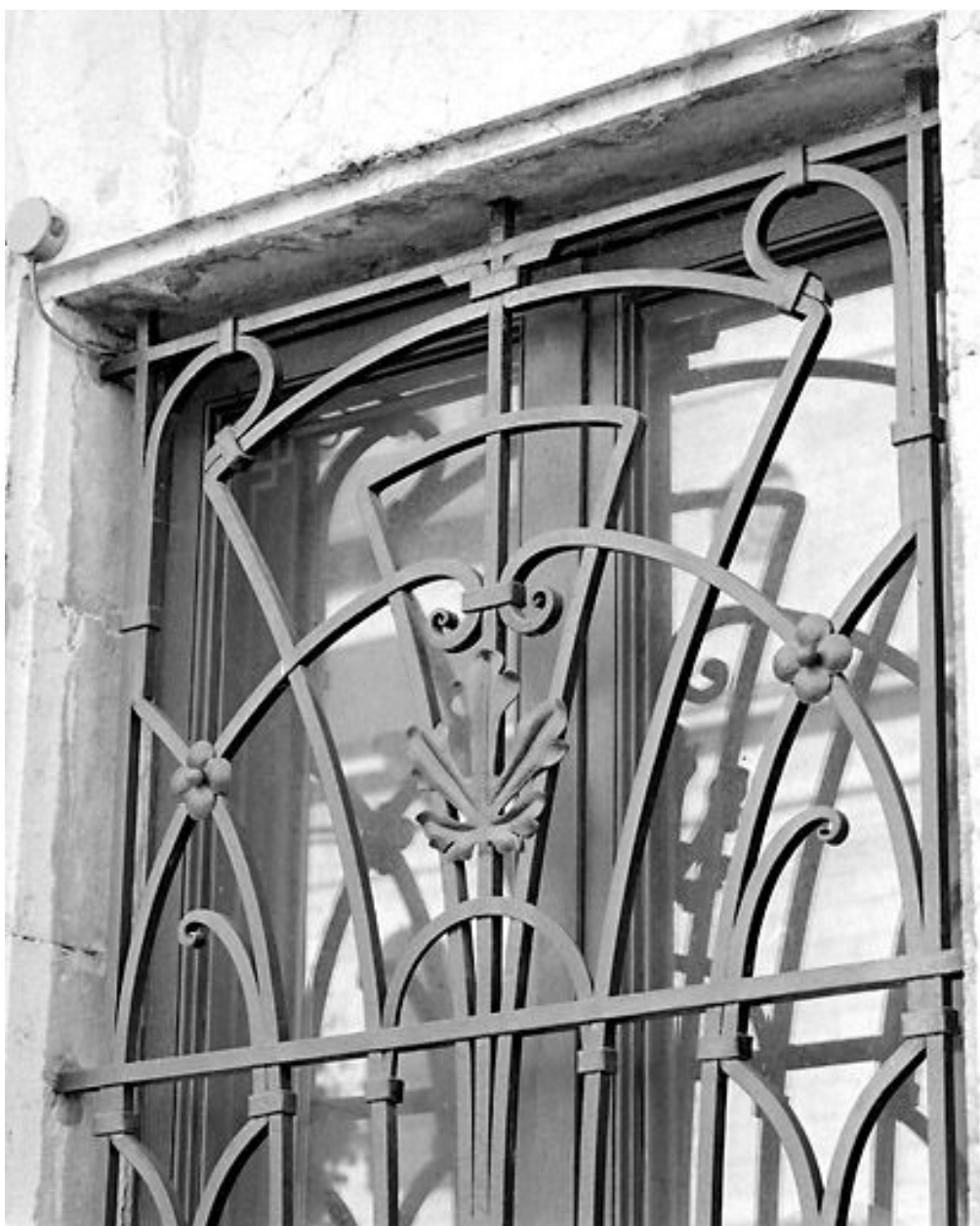
Façade latérale gauche : détail de la grille.
