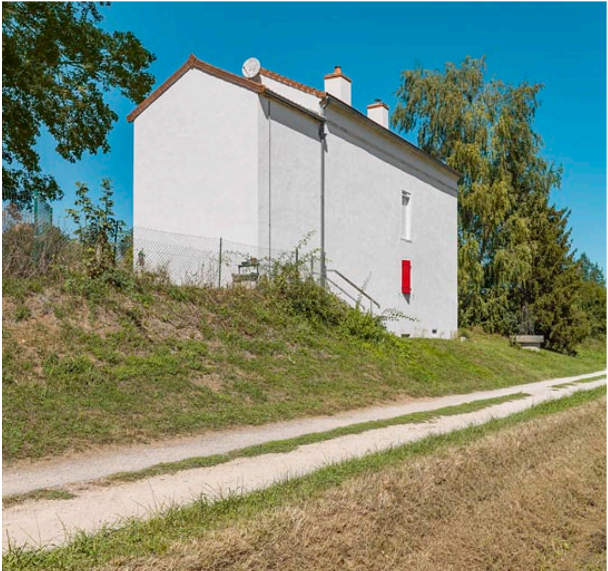
La maison éclusière de 3/4 : pignon de l'annexe latérale droite et face arrière.
