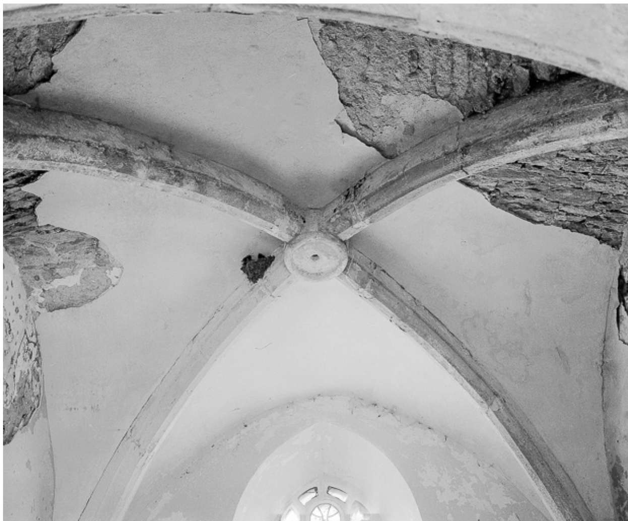
Intérieur : voûte de la chapelle latérale droite.
