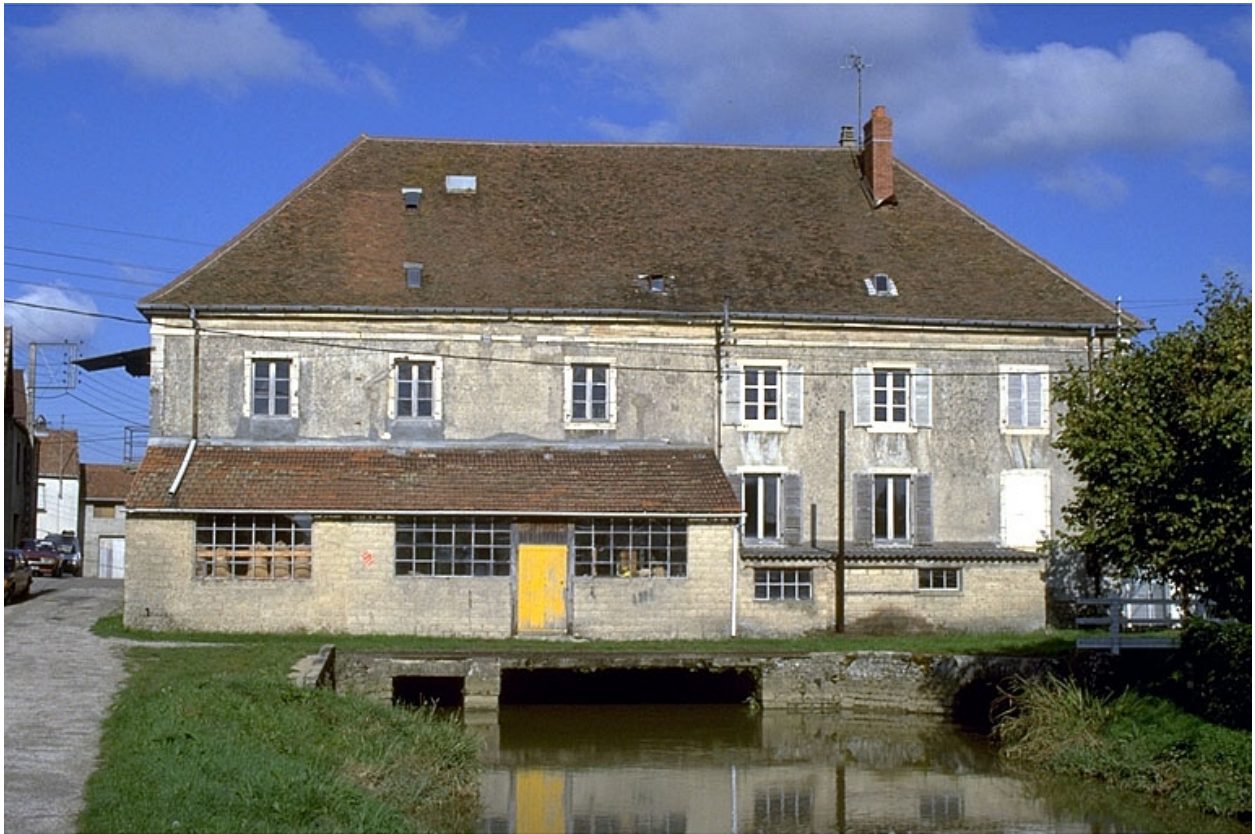
Façade postérieure de la minoterie.
