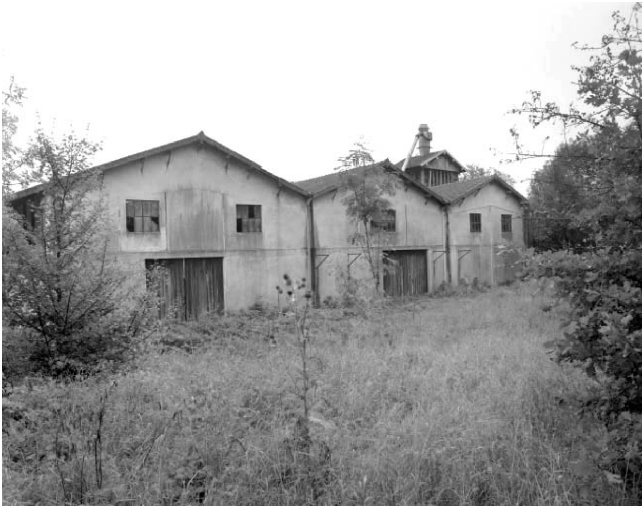
Façade postérieure de l'atelier de fabrication.
