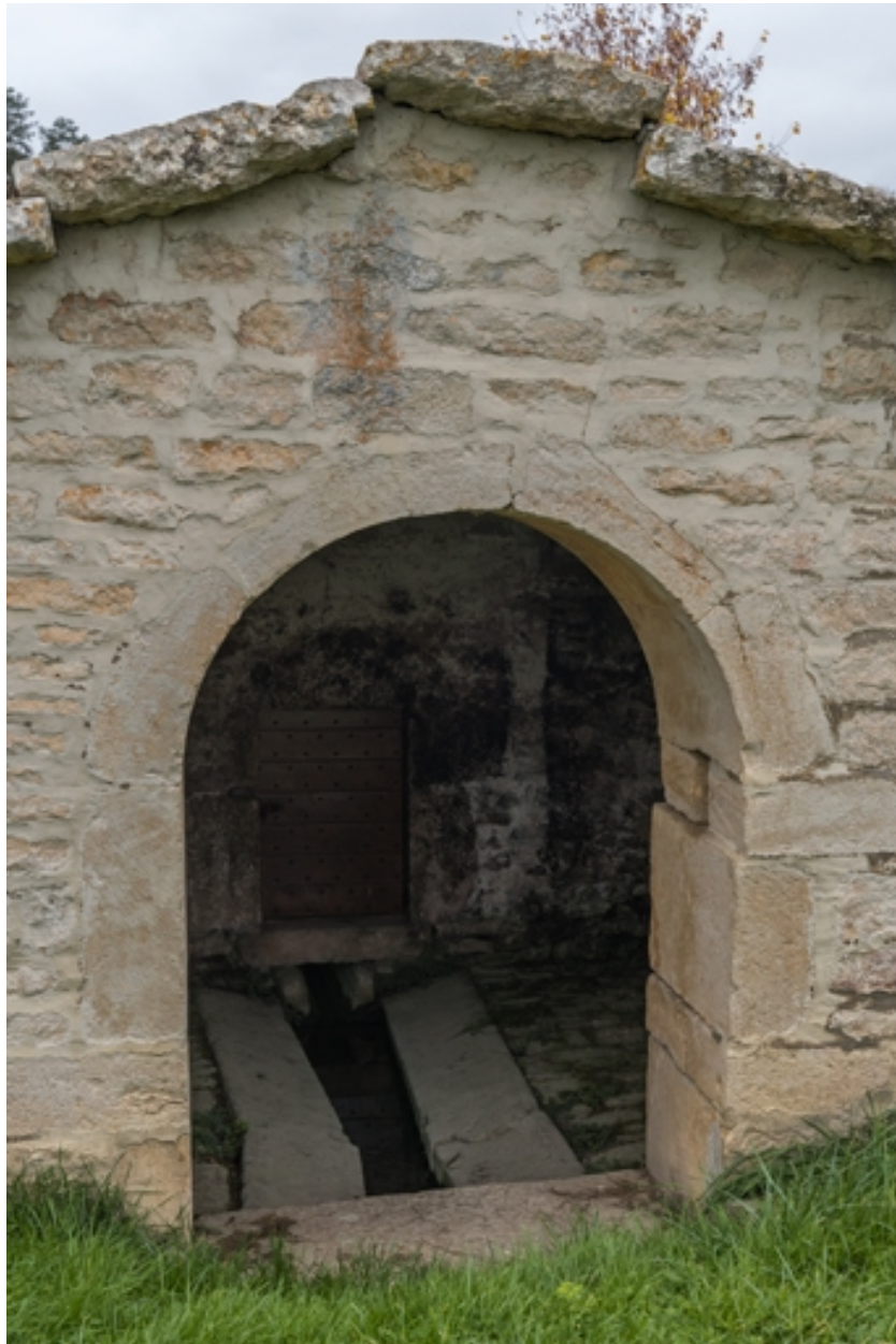
Détail de la façade est.
