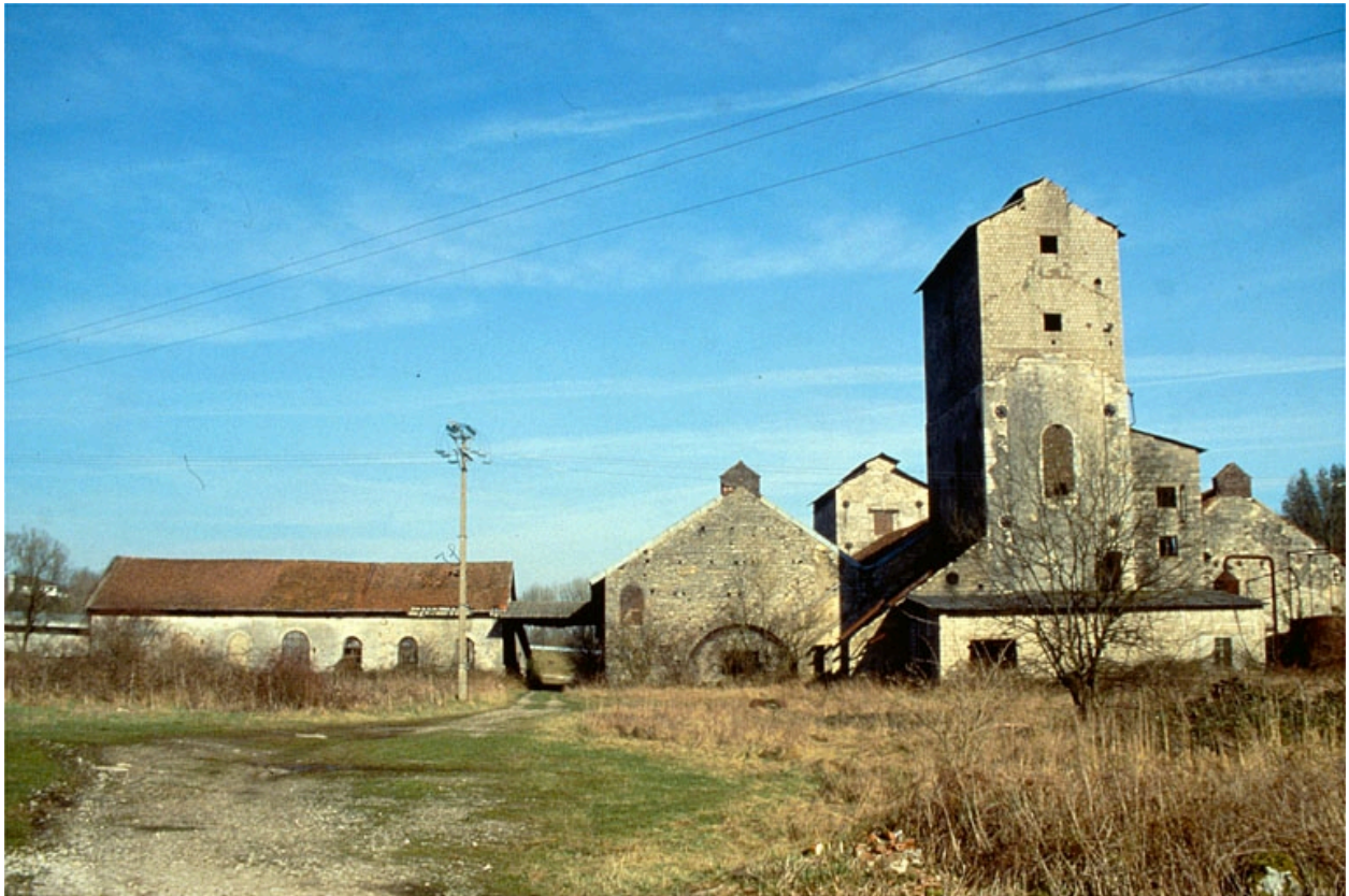
Vue d'ensemble depuis l'ouest : salle des machines (A) et atelier de fabrication.
