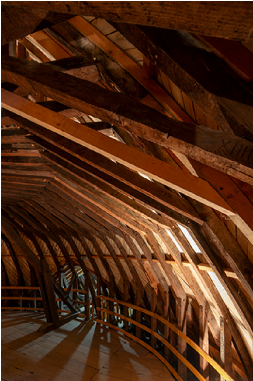
Parie orientale de la charpente, depuis le sud.
