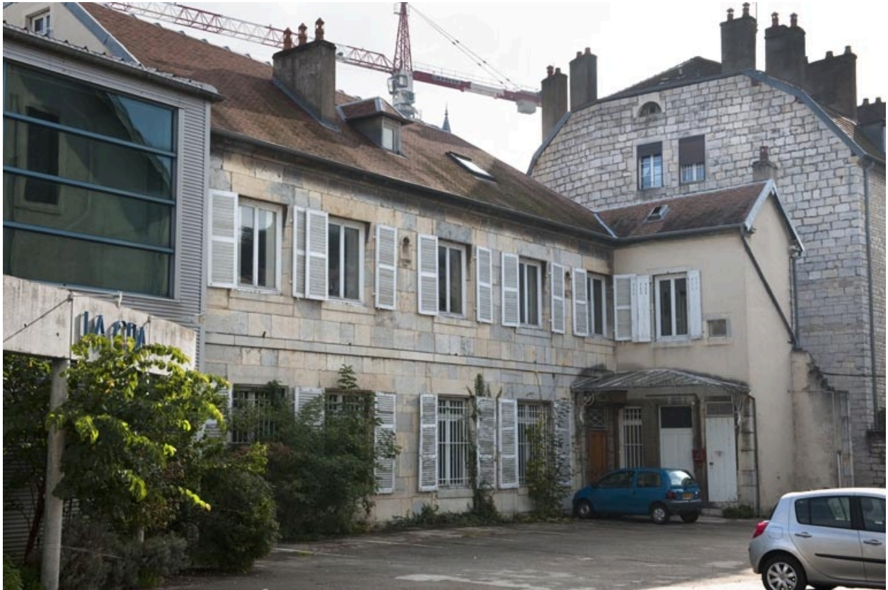
Logis au fond de la deuxième cour : vue d'ensemble de trois quarts gauche.
