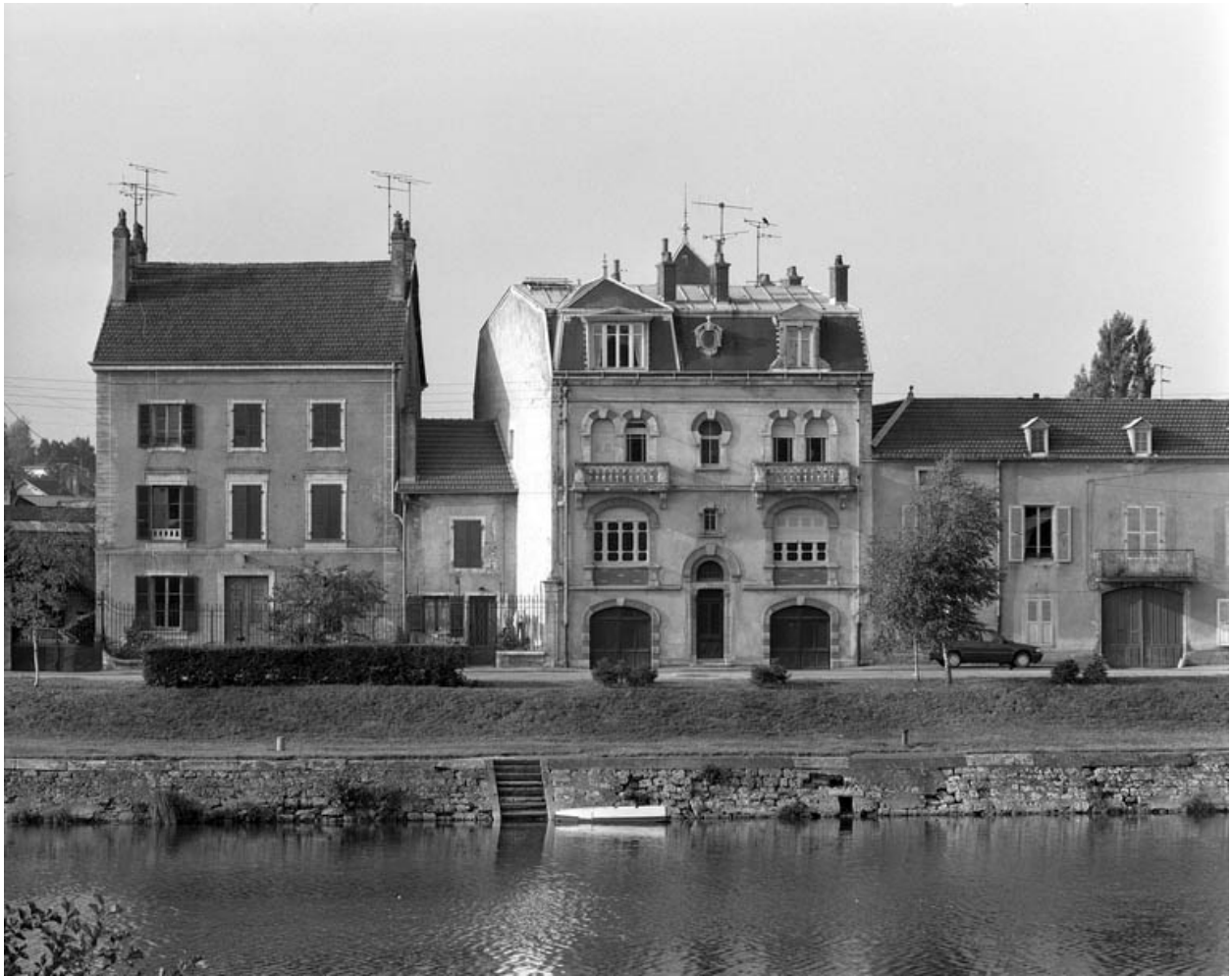
Vue d'ensemble depuis le quai Villeneuve.
