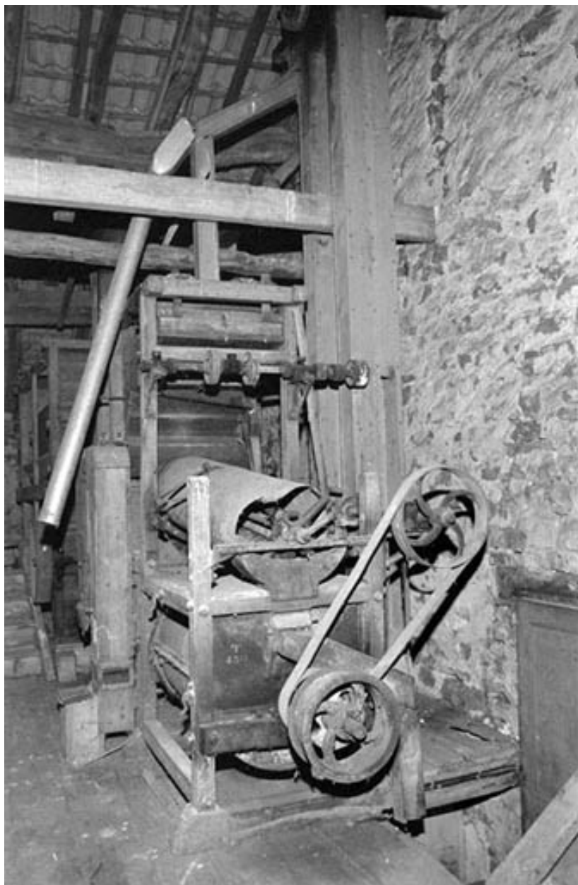
Trieur à grains (étage en surcroît).
