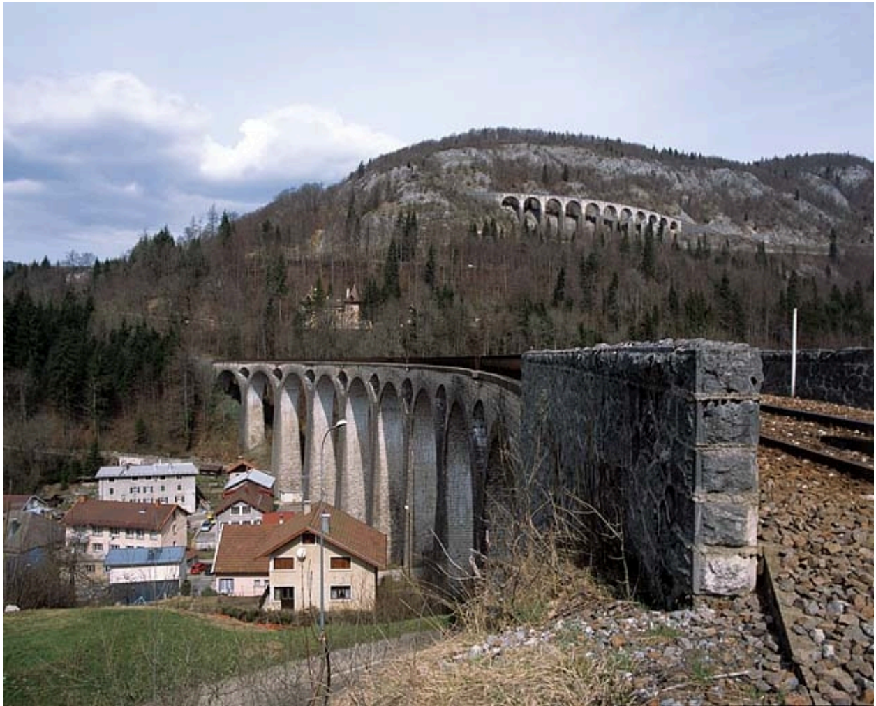
Parapet sud de la culée côté Andelot-en-Montagne.
