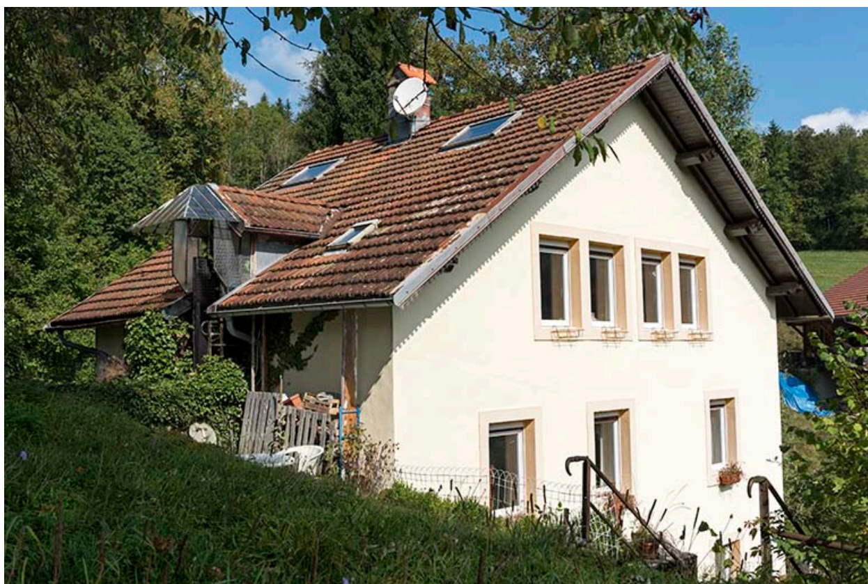
Façades antérieure et latérale droite.
