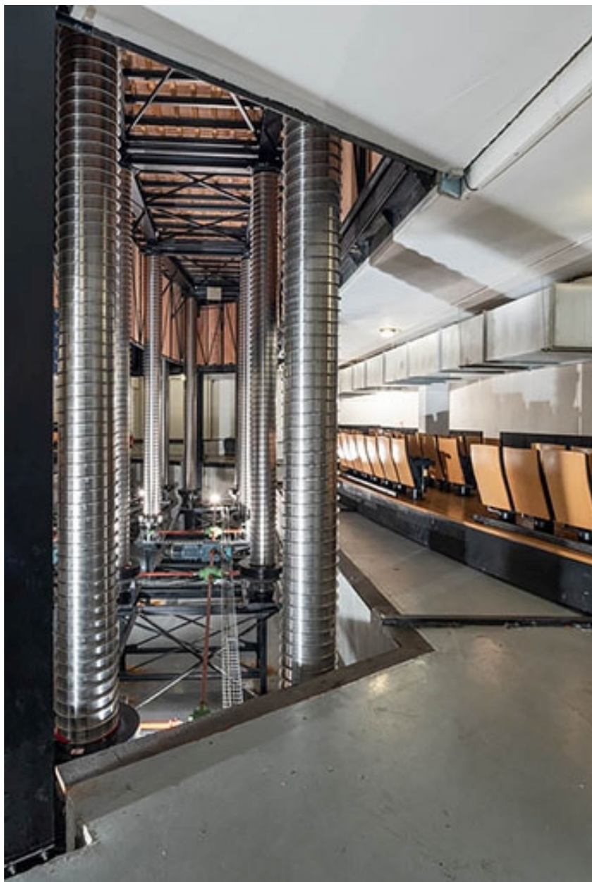
Avant-scène : vérins soutenant le plancher de la fosse d'orchestre (cadrage vertical).
