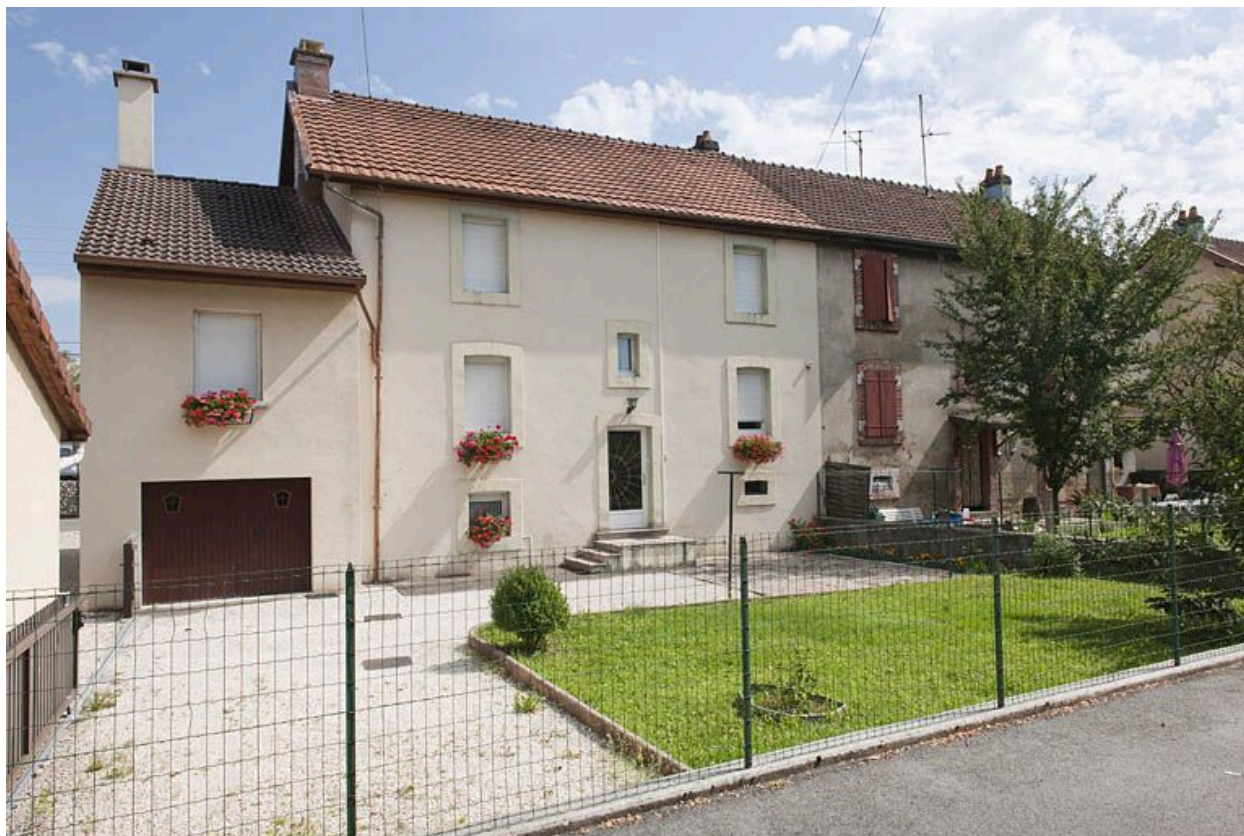
Rue de Verdun. Façade postérieure d'une habitation.
