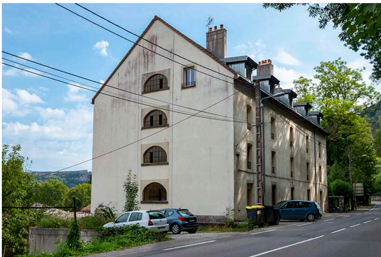
Logement ouvrier vu de trois quarts gauche.
