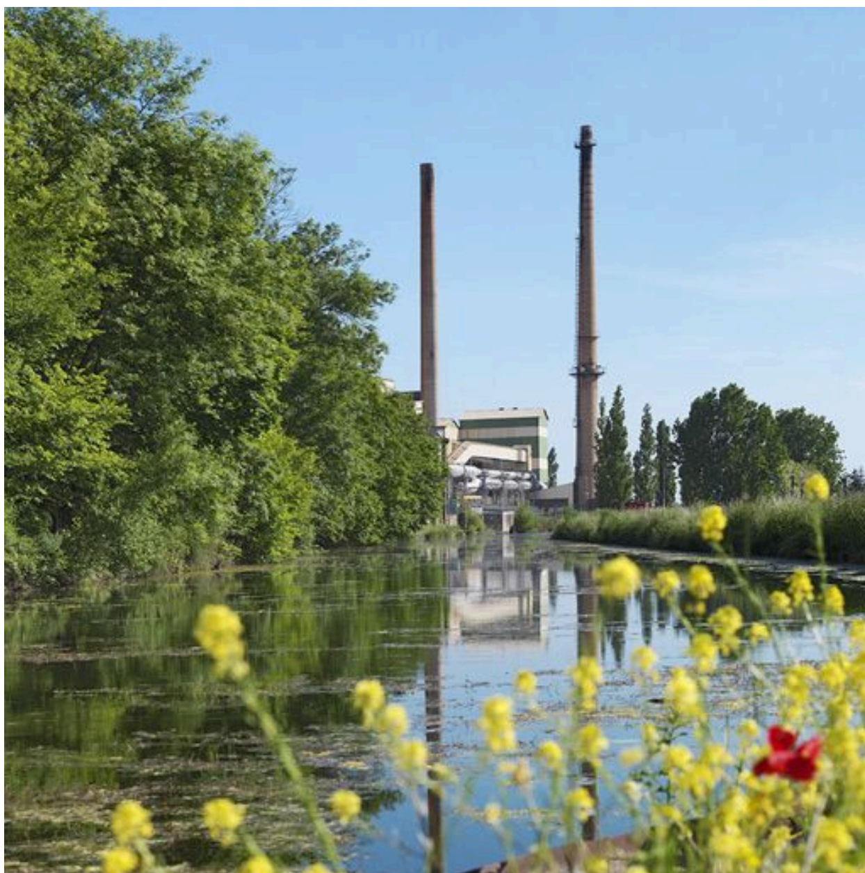
Vue générale de l'usine depuis l'embranchement.
