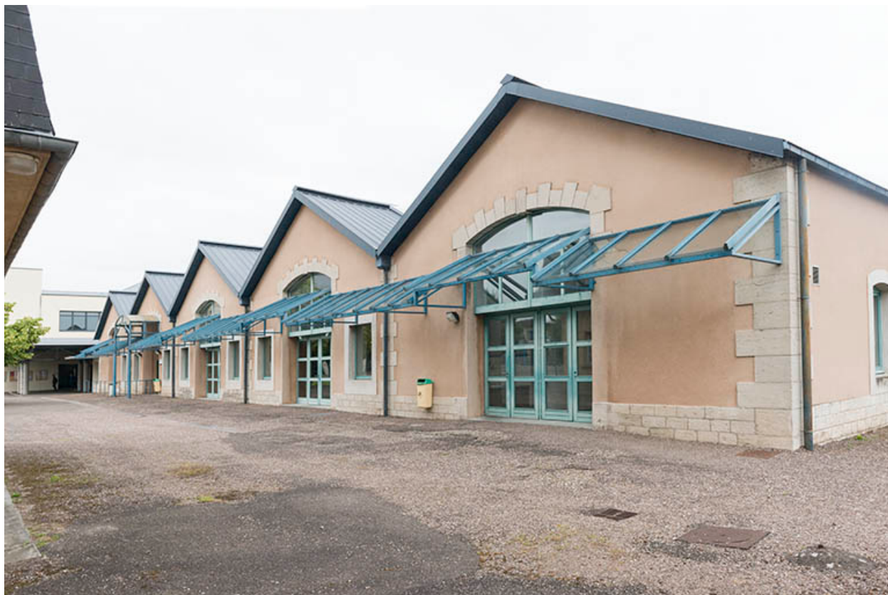
Façade sur cour de la cantine.
