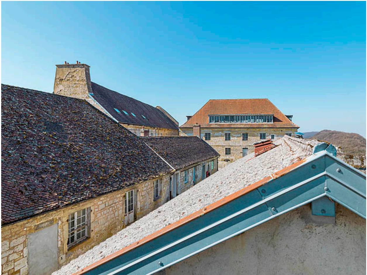
Toit à croupe du bâtiment.
