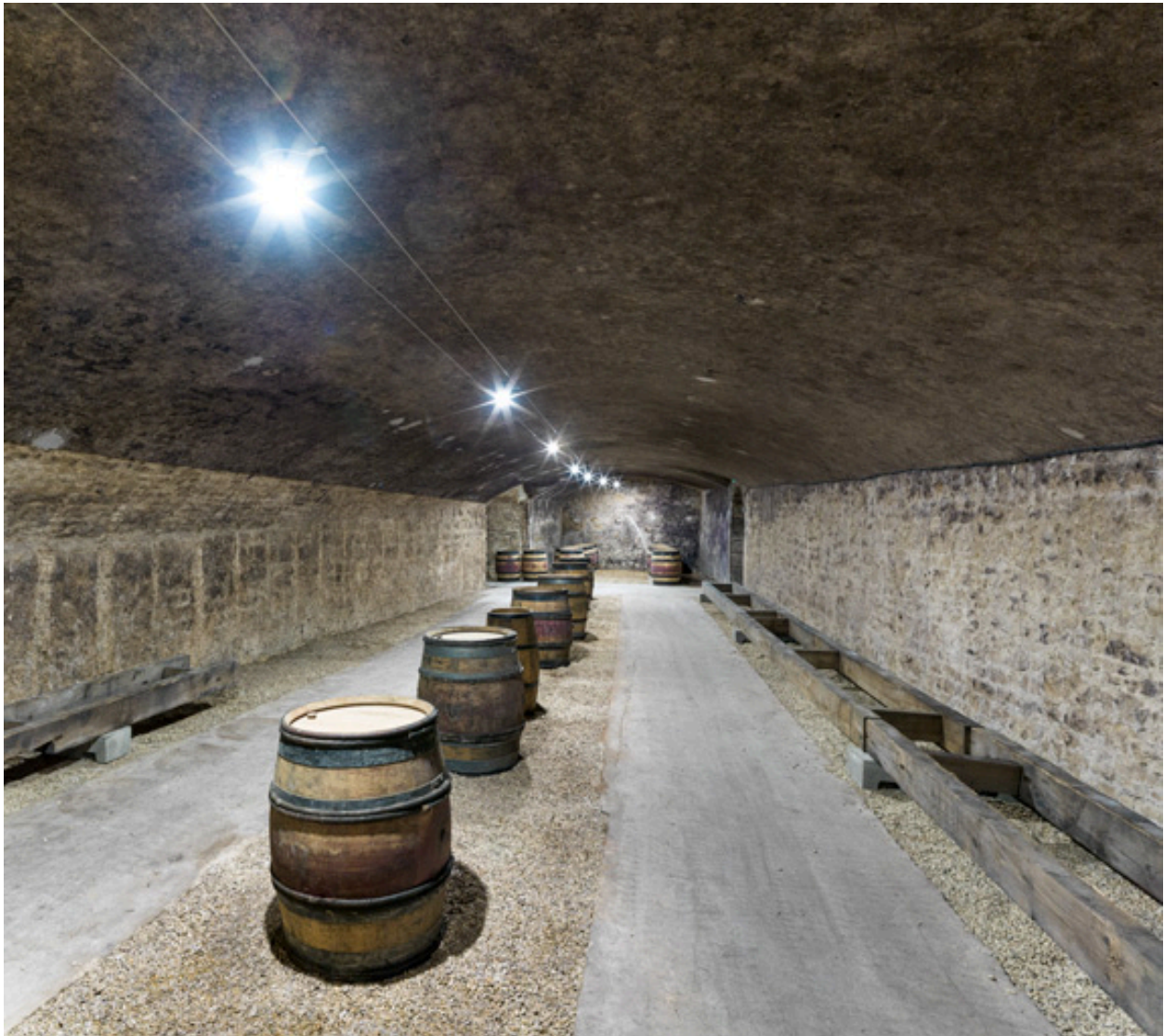
Caves, rez-de-chaussée : vaisseau central.
