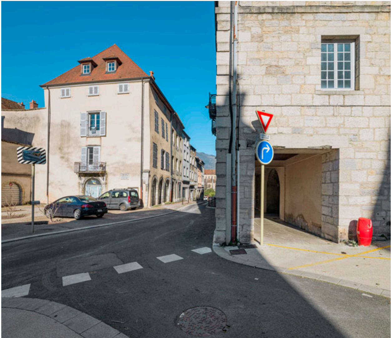
Immeuble sur rue. Vue d'ensemble depuis le bas de la rue Charles Magnien.
