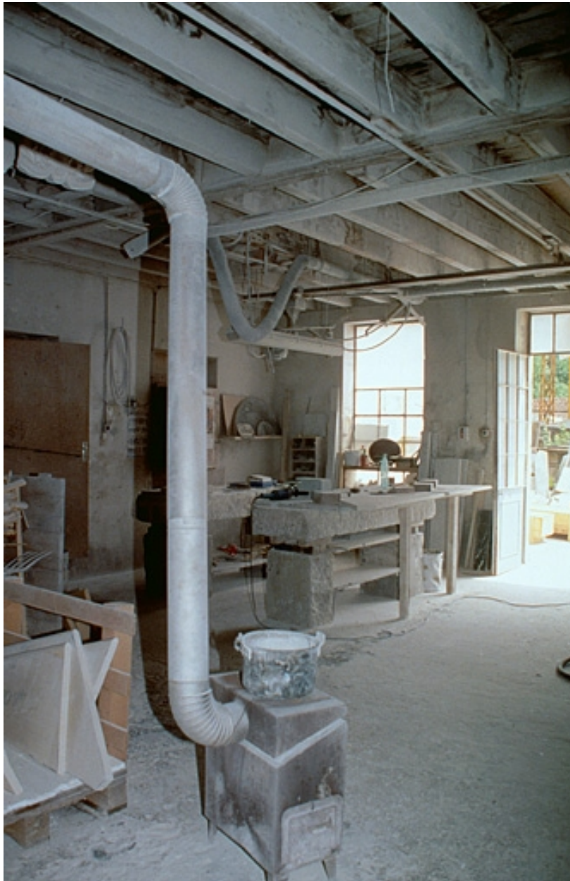
Intérieur de l'atelier des marbriers (F4).
